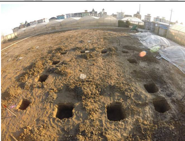
05). All excavation complete
