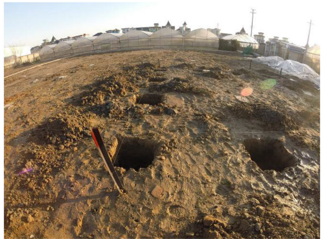
04). Excavation in progress
